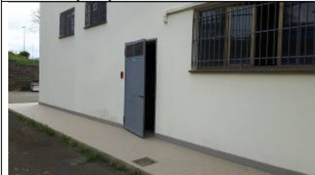
Immagine 19 Vista accesso locale centrale termica
