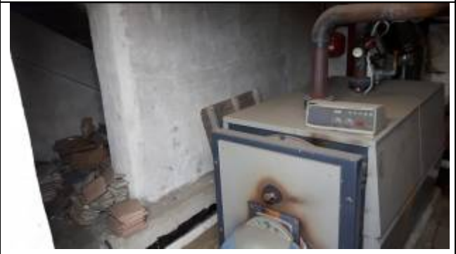
Immagine 20 Vista interna locale centrale termica
