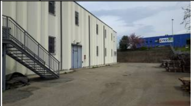
Immagine 04 Vista area pertinenziale esterna
