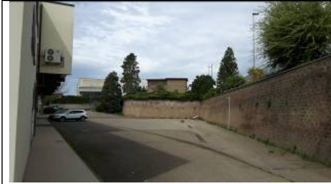
Immagine 01 Vista area pertinenziale esterna (in fondo cabina ENEL)
