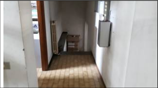
Immagine 18 Vista corridoio di accesso seminterrato
