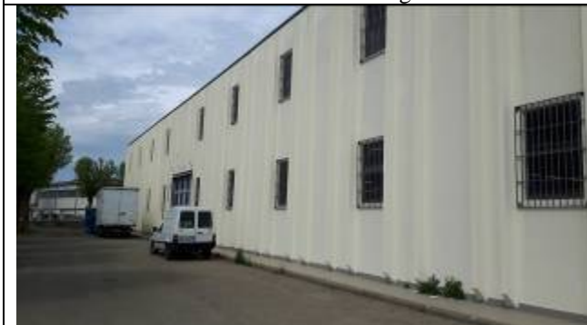
Immagine 05 Vista area pertinenziale esterna
