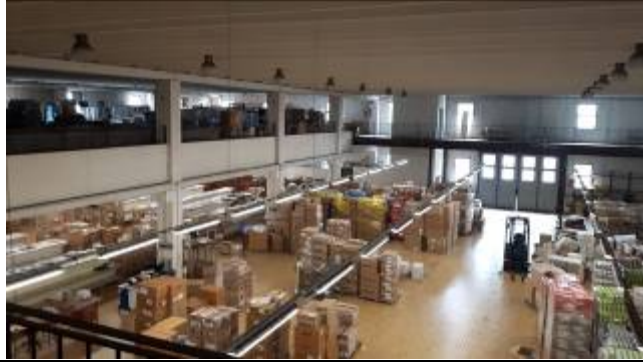
Immagine 9 Vista interno capannone lato sx
