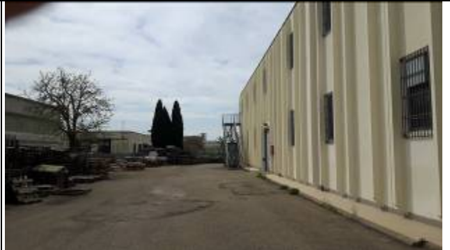
Immagine 02 Vista area pertinenziale esterna
