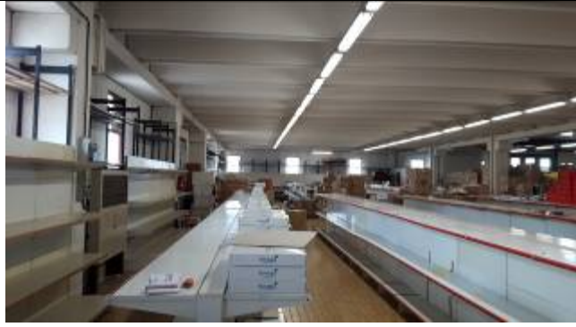
Immagine 13 Vista interna piano terra capannone
