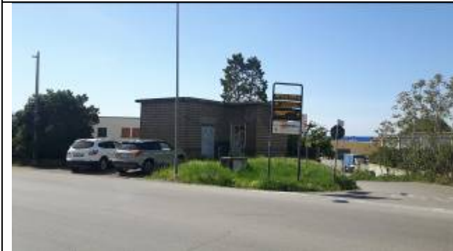
Immagine 21 Vista esterna cabina elettrica
