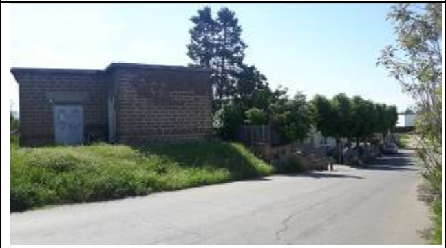
Immagine 22 Vista esterna cabina elettrica
